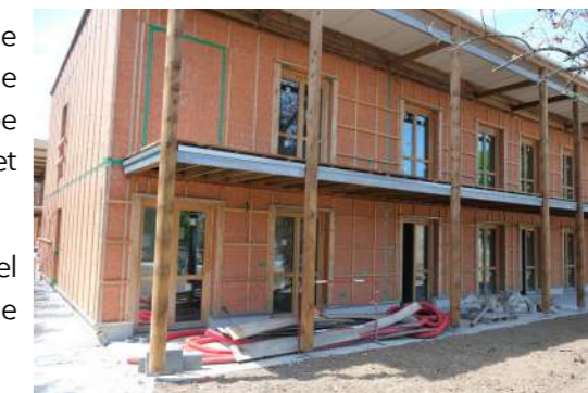
Chantier de la Garenne
