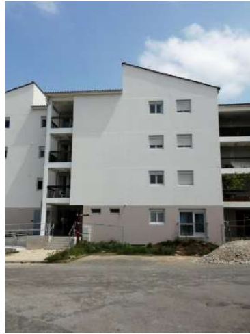
Ravalement de façade du bâtiment B à la Couronne
