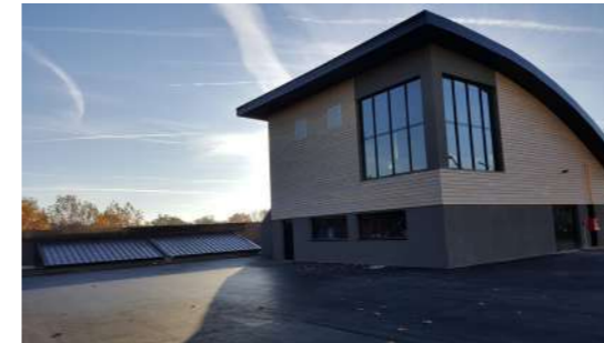
La chaufferie bois de la Petite Garenne alimente notamment 279 logements.
