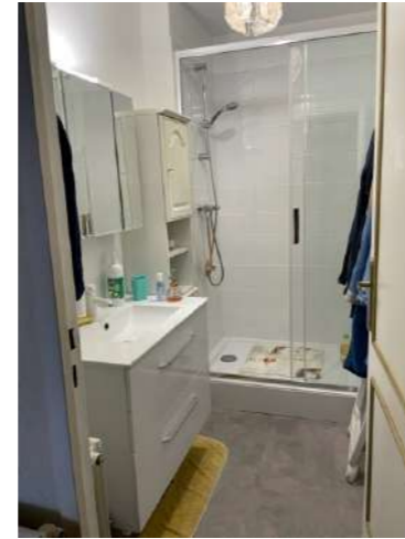
Réfection des salles de bain
