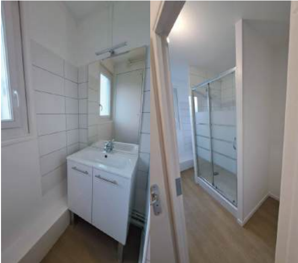
Salle de bain rénovée
