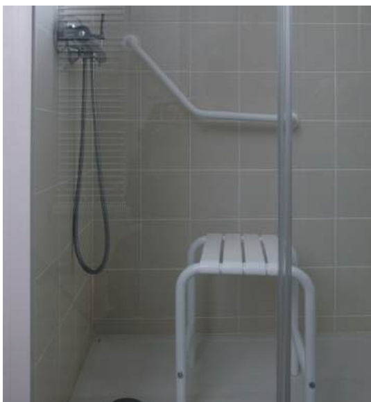
La demande d'adaptation la plus fréquente est l'installation d'une douche avec une barre de maintien.
