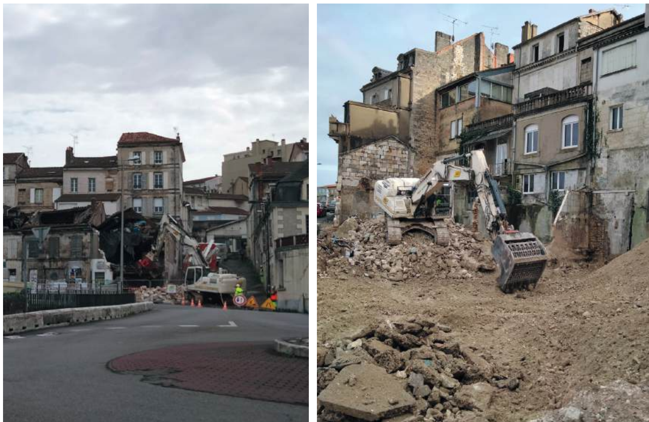
Démolition de l'îlot « Denis Papin »
