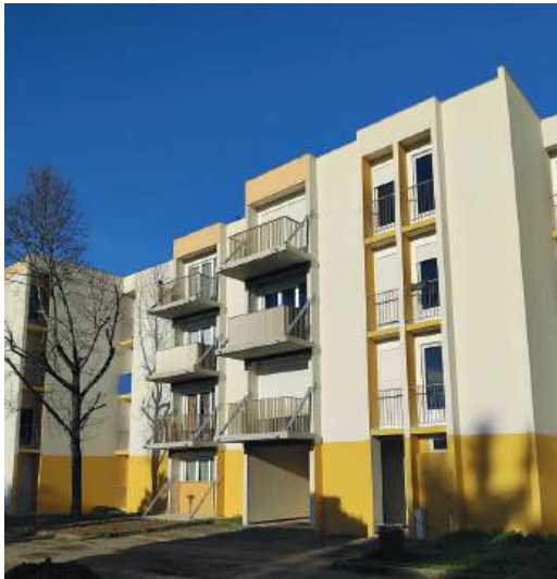
Après ravalement et pose des balcons
