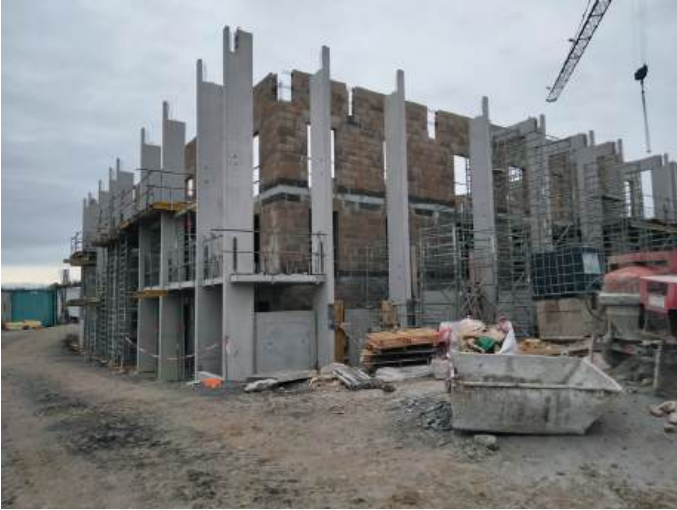
Construction de 39 logements à Ruelle sur Touvre
