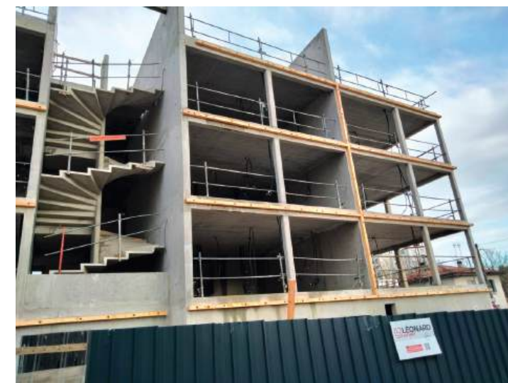
Construction de l'extension du Foyer des Jeunes Travailleurs
